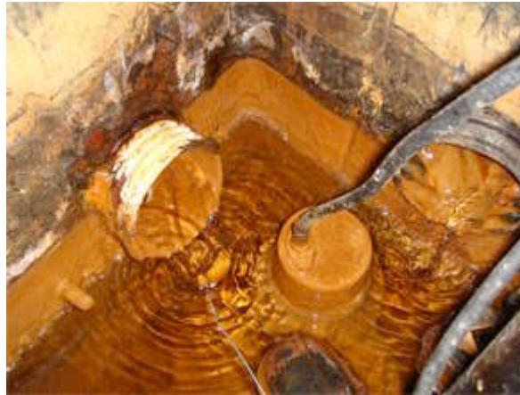
Dépôt de boue gluante de couleur ocre dans le bassin de captation des eaux pluviales
