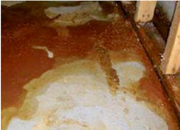
Dépôts rougeâtres sur la dalle de béton des sous-sols
