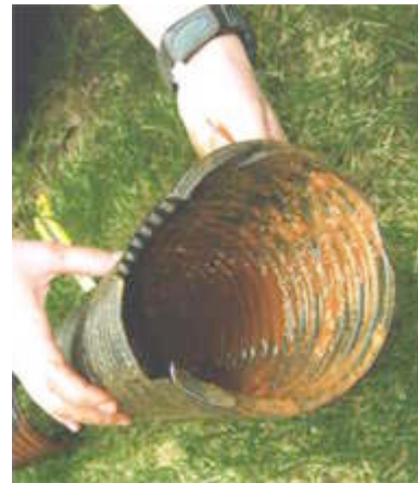
Dépôt sur les parois d'un drain de fondations
